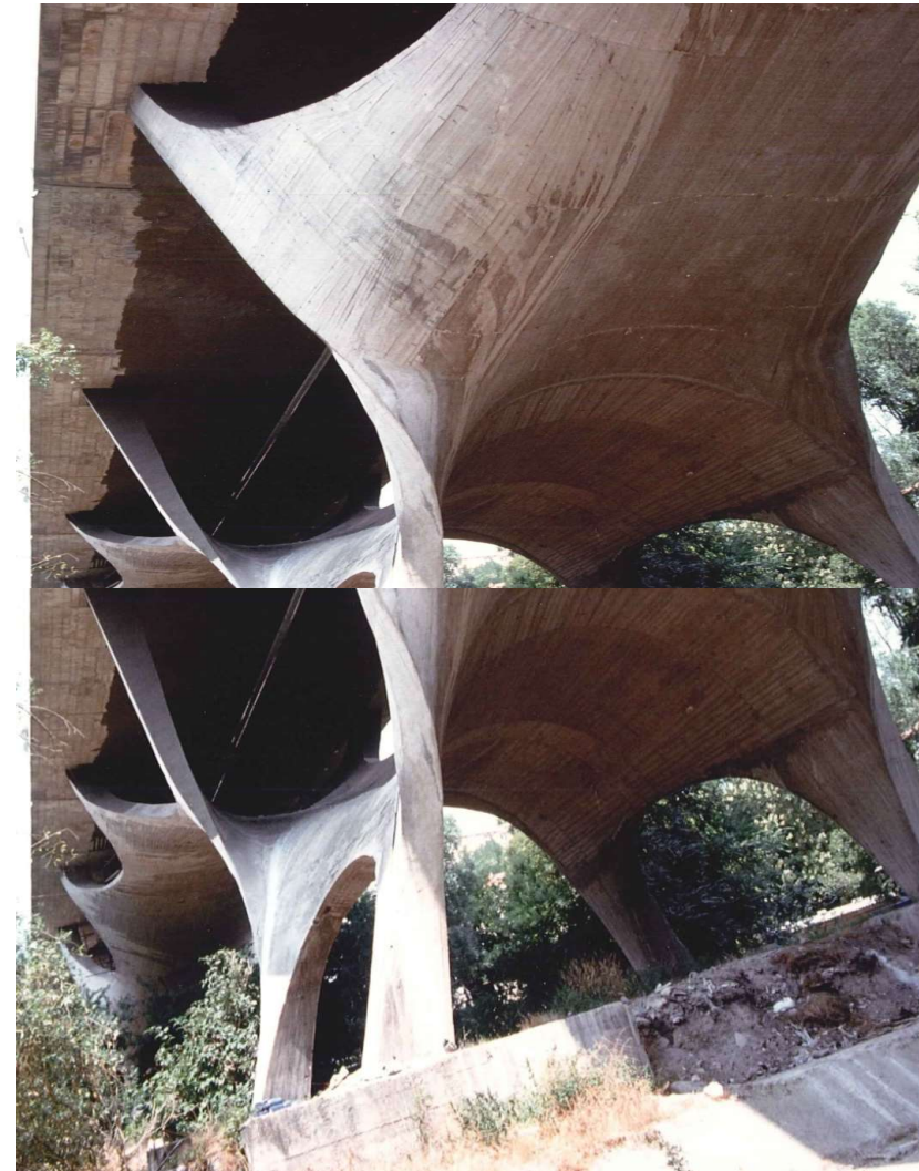
Viadotto sul Basento (1967-1976) – Sergio Musumeci
